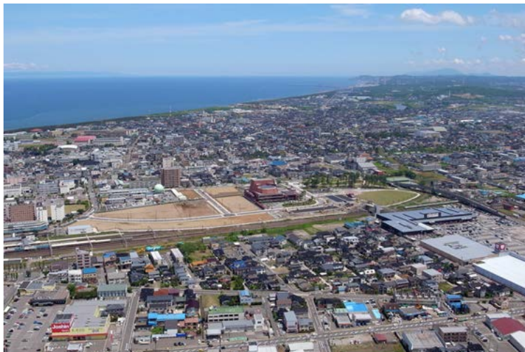
新庁舎建設予定地
