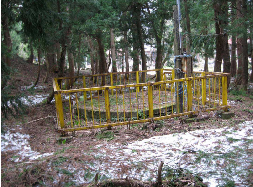
【栃ヶ原地すべり第一号集水井 全景（南側より） 新潟県撮影】
