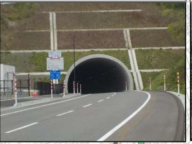
【写真③】柏崎トンネルの状況
