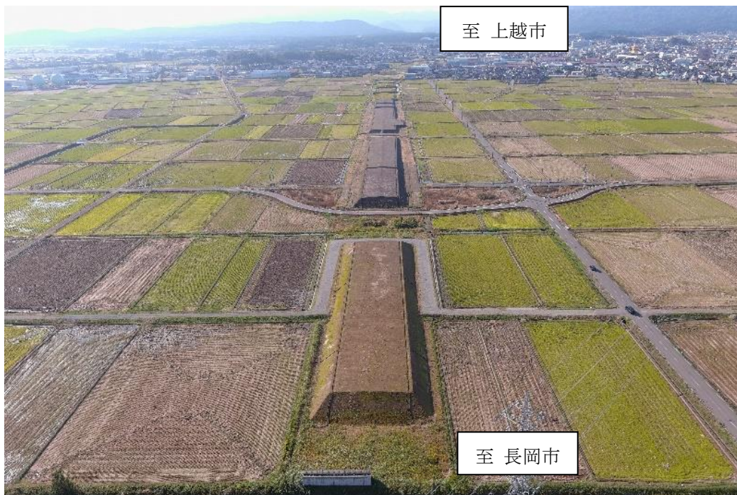
載荷盛土状況（宝田工区）（令和3（2021）年11月撮影）
