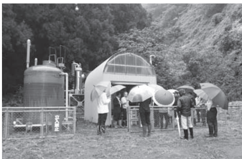
源泉ポンプの稼働状況を確認する議員
