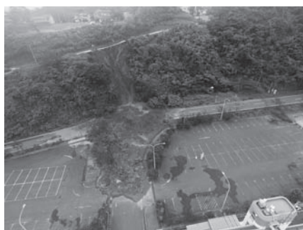
被災状況を上空から撮影（東の輪地区）
