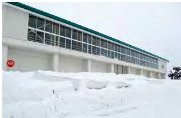
大雪で壊れたフェンス▶
