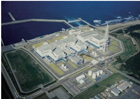
柏崎刈羽原子力発電所
