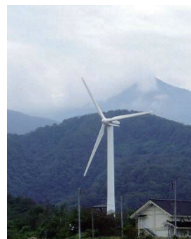
風の丘風力発電所
