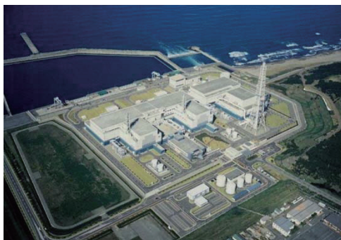
柏崎刈羽原子力発電所
