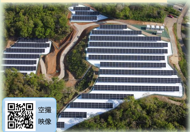
鯨波太陽光発電所 (旧かしわ荘跡地)
