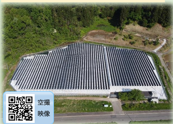
西長鳥太陽光発電所 (北条北小学校跡地)
