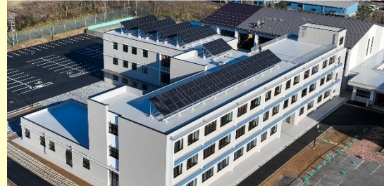
太陽光：約65kW 蓄電池：約45kWh
