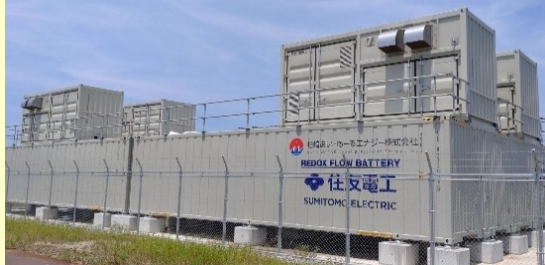
住友電気工業のレドックスフロー電池 8,000kWh
