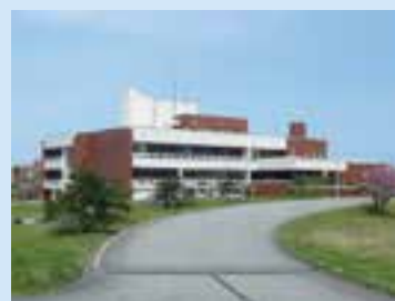
▲自然環境浄化センター
