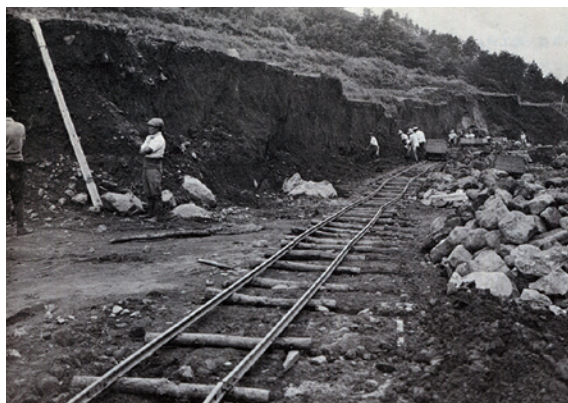
▲手作業での工事の様子
