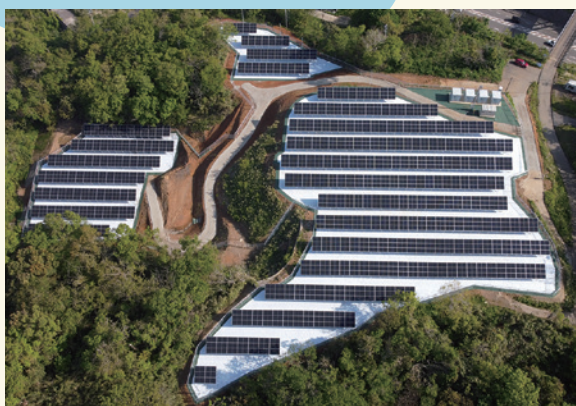
鯨波太陽光発電所
