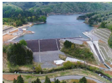
試験湛水中の市野新田ダム
