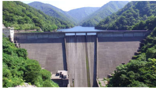
初めて内部が公開される赤岩ダム
