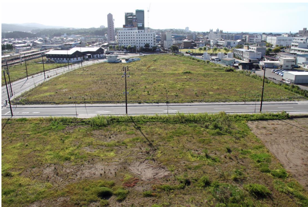
柏崎市新庁舎建設用地
