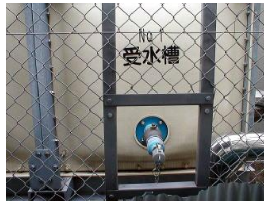
災害時に飲料水として使える受水槽のイメージ
